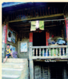
富宁县平坤村干栏式房屋。 A ganlan style house in Pingkun Village.
